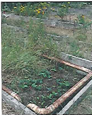
Die alten Heizungsrohre in den Hochbeeten müssen bleiben.
